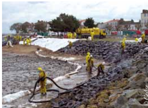
Chantier de nettoyage mécanique sur enrochements
