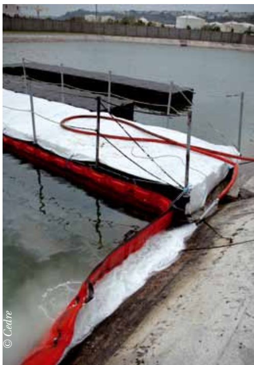
Protection d'un ponton flottant par géotextile
