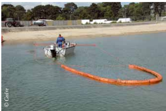
Récupération dynamique d'une pollution de faible ampleur à l'aide d'un barrage absorbant à jupe lestée et d'une embarcation légère
