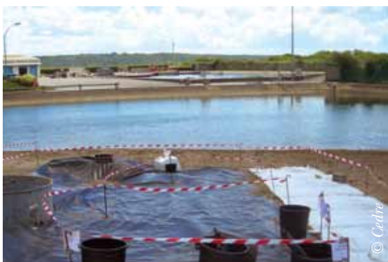
Aménagement des aires de décontamination et déchets.
