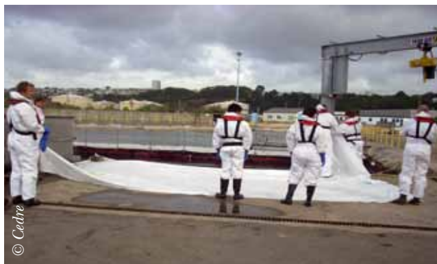
Protection du quai avec du géotextile
